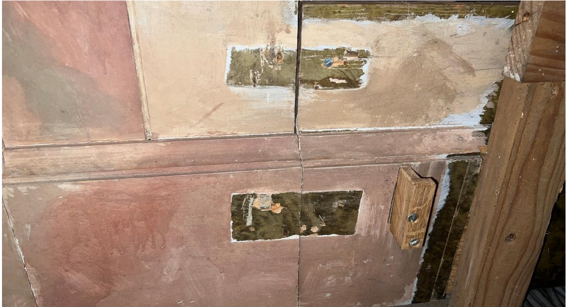
Abbildung 51 Rückstände von Veränderungen am Gehäuse C-Seite
