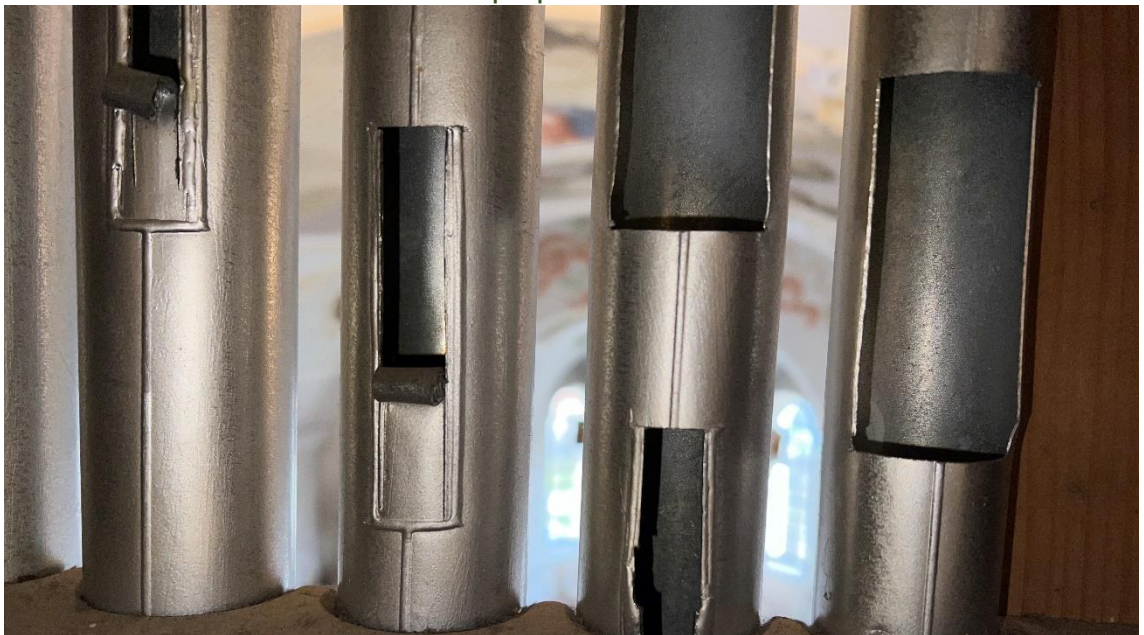
Abbildung 6 Stimmvorrichtungen der Prospekt Pfeifen
