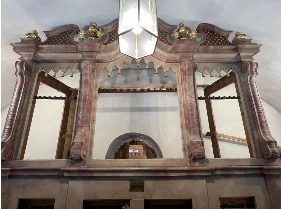
Abbildung 50 Gehäuseansicht ohne Pfeifenwerk
