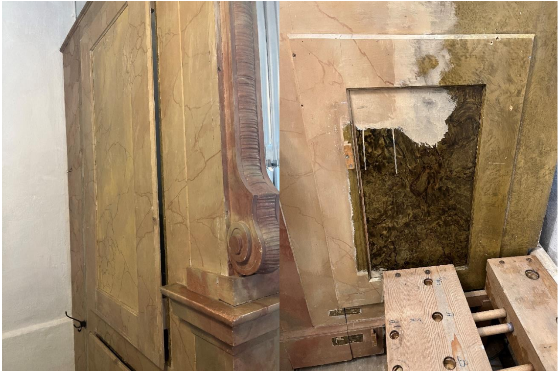
Abbildung 53 Abgerückte Gehäusefüllungen (links), Frühere Marmorierung des Gehäuses (rechts)
