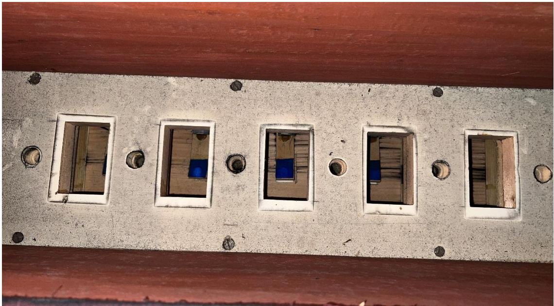
Abbildung 33 Registerkanal und Kanzelleneinlässe
